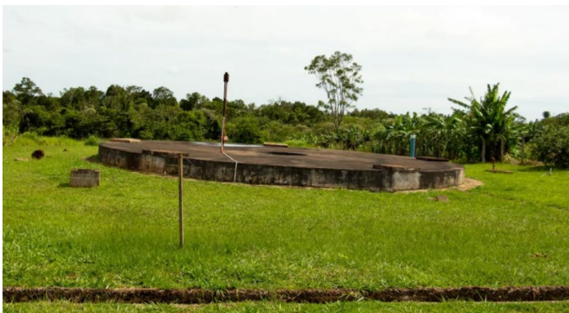
Figura 23 - Reator anaeróbio de leito fluidizado no município de Antônio João, MS.
