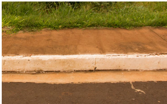
Figura 26 - Meio-fio no município de Antônio João, MS.
